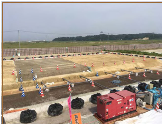
盛土施工状況(2層目)
