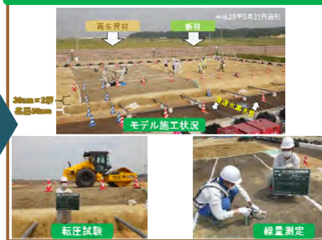
e. 試験盛土の施工
