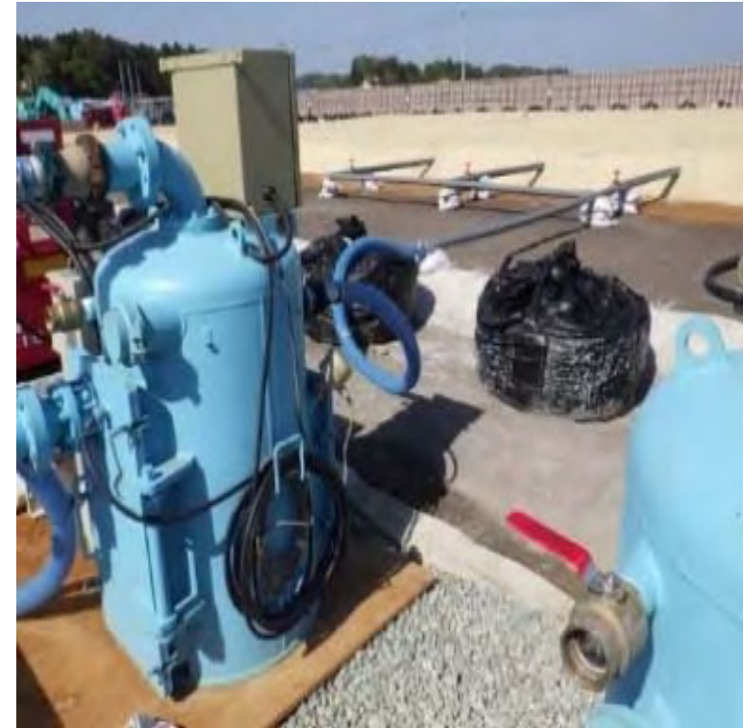
浸透水の集水設備の概観
