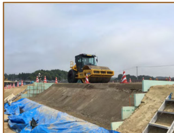
転圧状況(4層目)
